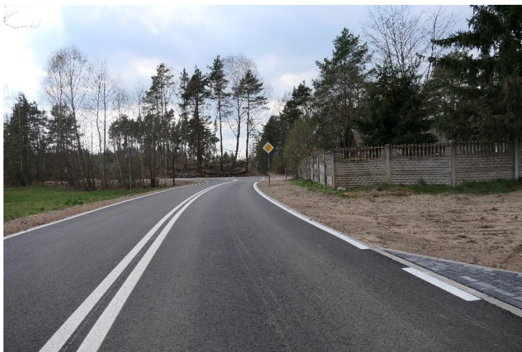
Rysunek 14: Budowa drogi w Majdanie
