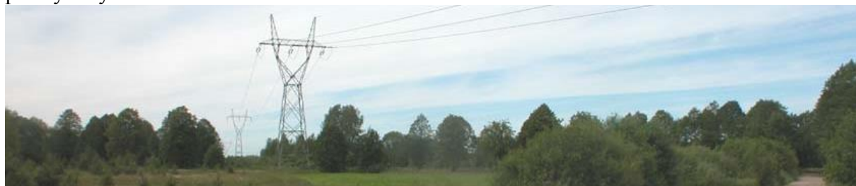
fot. 10 Linia 220 KV w rejonie Budzisk (przecięcie z droga krajowa nr 62.
