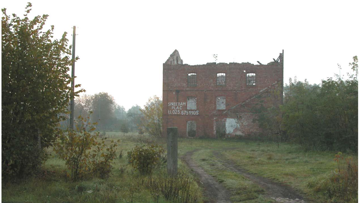
fot. 37 Ruiny Młyna Eychlera - widok od strony drogi krajowej nr 50.
