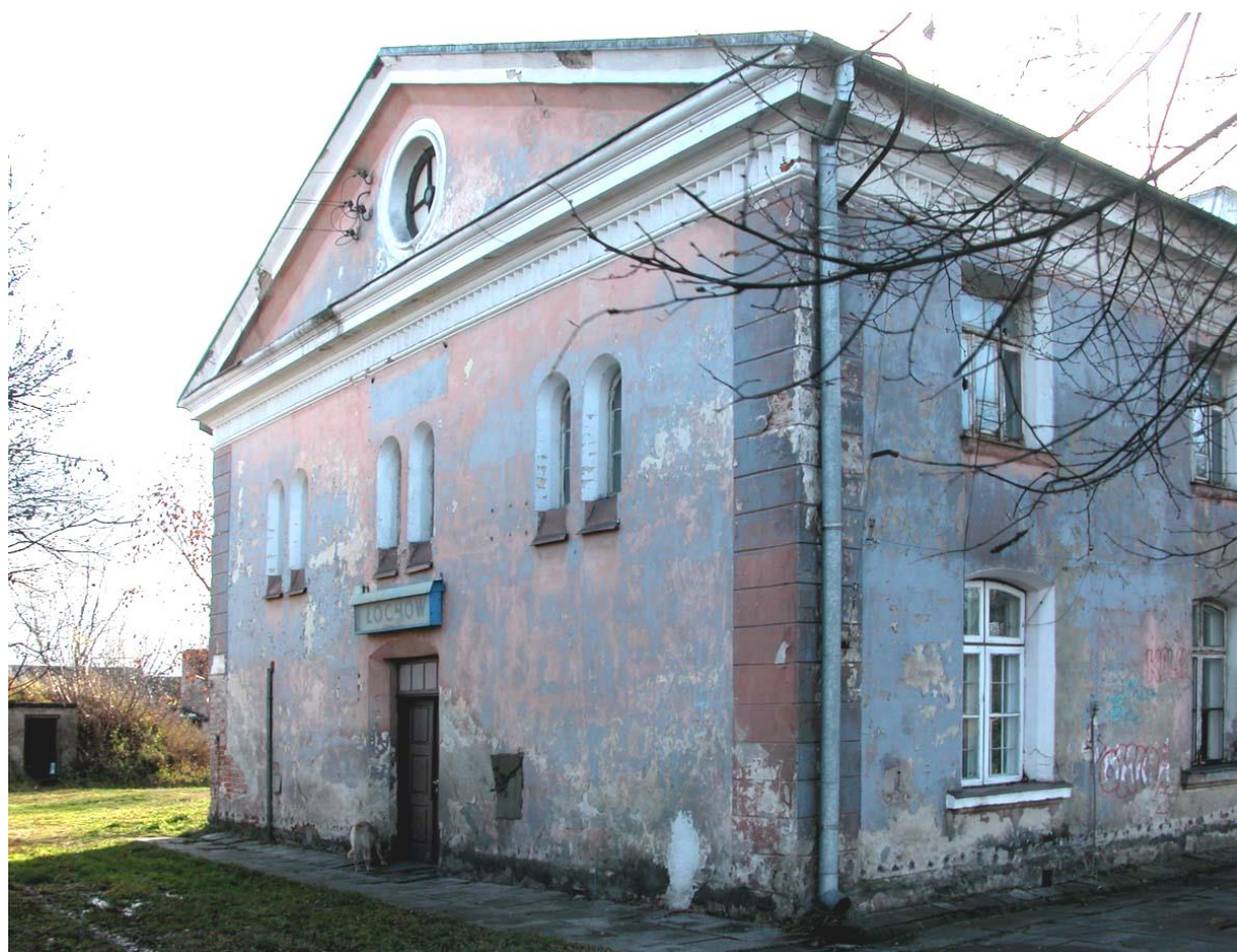
fot. 40 Łochów – Zespół Dworca Kolejowego - dworzec, elewacja szczytowa - październik 2004 r.
