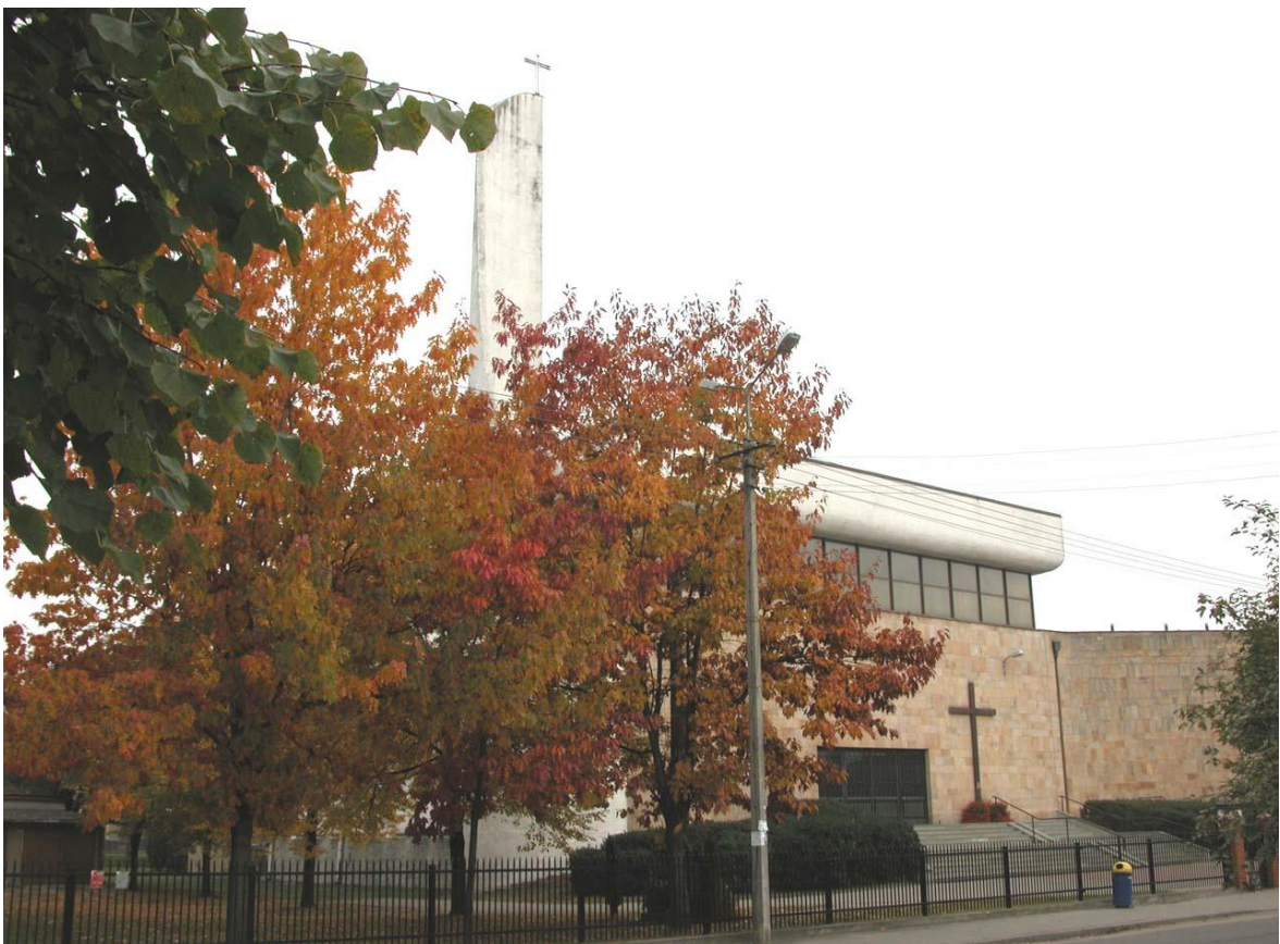
fot. 103 Kościół w Łochowie - wejście główne
