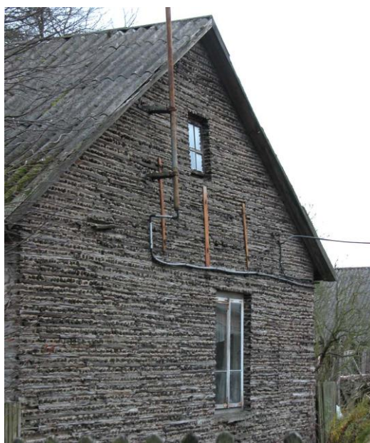
fot. 45 Łosiewice - przykład drewniano-murowanej technologii budowy domów
