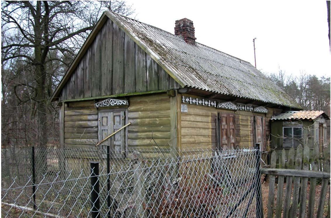
fot. 73 Losiewice - zanikający detal wieńczący ściany
