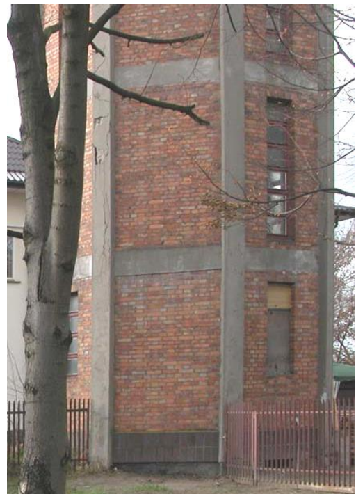
fot. 101 Podstawa Wieży.
