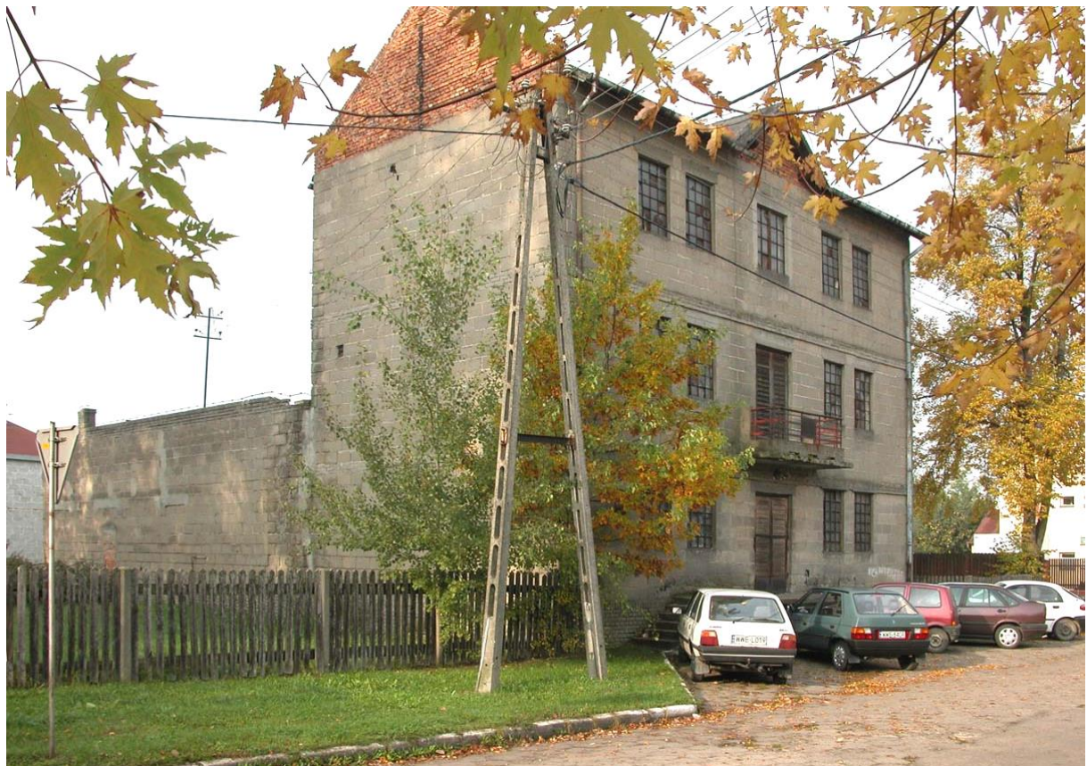
fot. 39 Młyn Gotowickich - elewacja szczytowa.
