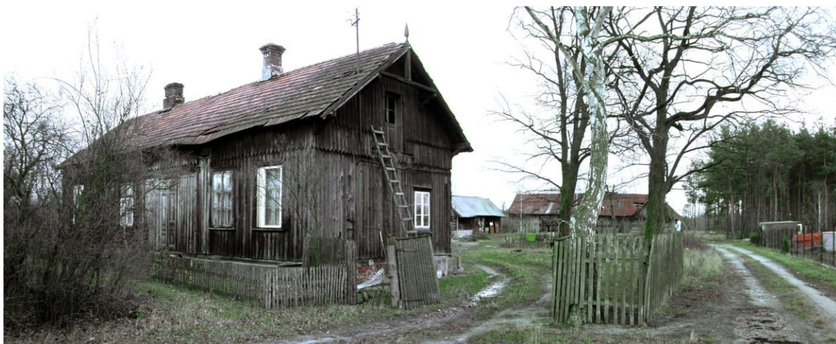
fot. 78 Jasiorówka - budynek drewniany ze sterczanem i poprzeczną belką na szczycie;
