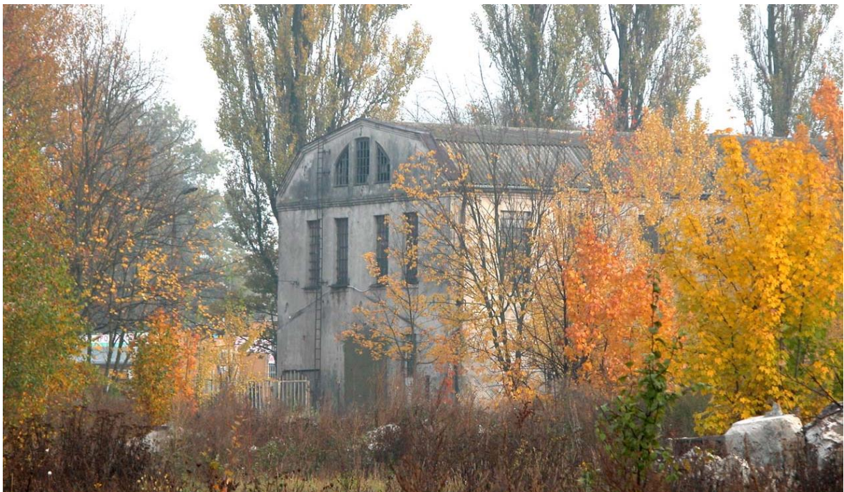
fot. 29 Fabryka w Ostrówku - szczyt budynku obróbki mechanicznej – październik 2006 r.
