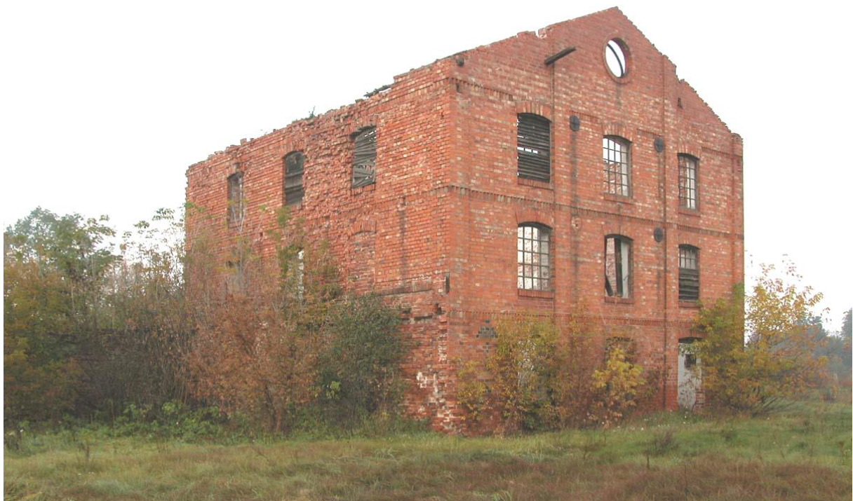
fot. 36 Ruiny Młyna Eychlera - elewacja i ściana szczytowa - październik 2006 r.
