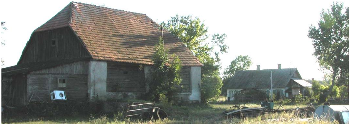
fot. 17 Brzuza - folwark - spichlerz – elewacja wschodnia i północna, na drugim planie rządówka.
