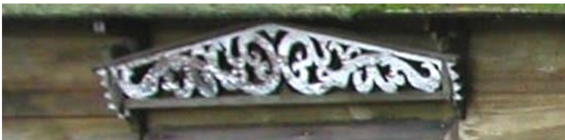
fot. 58 Łosiewice – „korona” nadokienna
