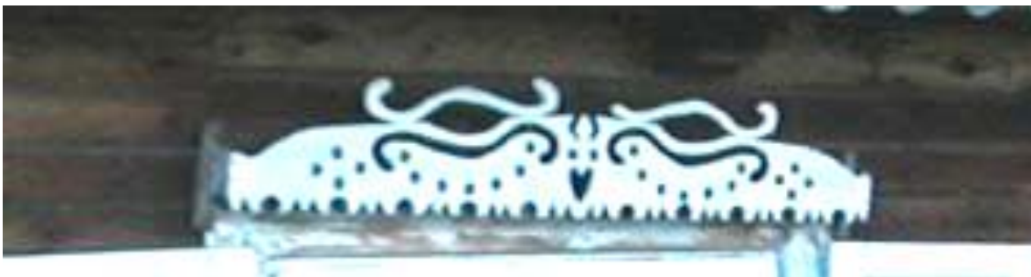
fot. 61 Brzuza - „korona” nadokienna okna.
