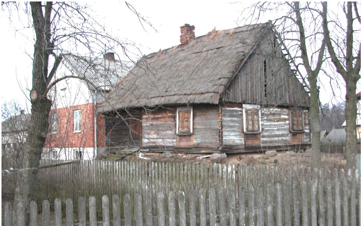
fot. 51 Brzuza - zabytkowy dom drewniany - na drugim planie widoczny nowy dom budowany tuż za starym (listopad 2005 r).
