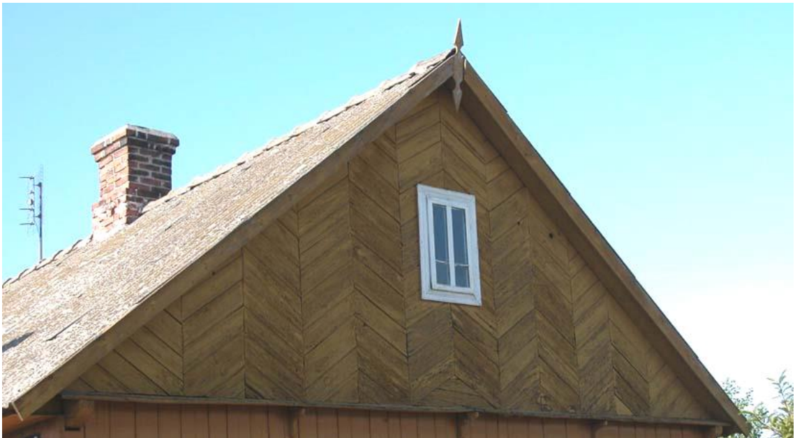
fot. 66 Nadkole – szczyt deskowany w jodelkę z ozdobnym sterczanem.
