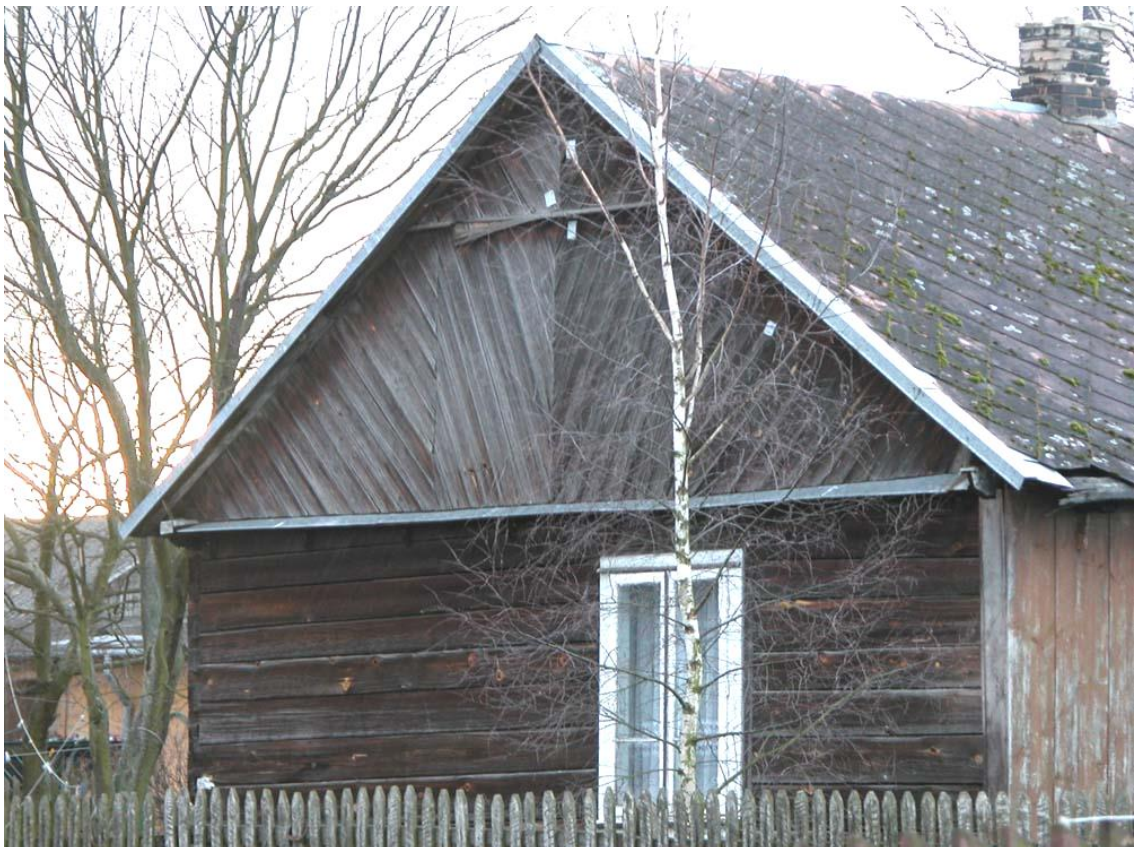
fot. 74 Losiewice - rzadko spotykane deskowanie szczytu
