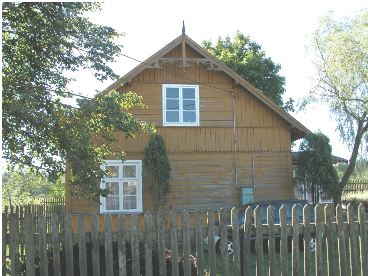
fot. 77 Nadkole - zdobienia szczytu domu
