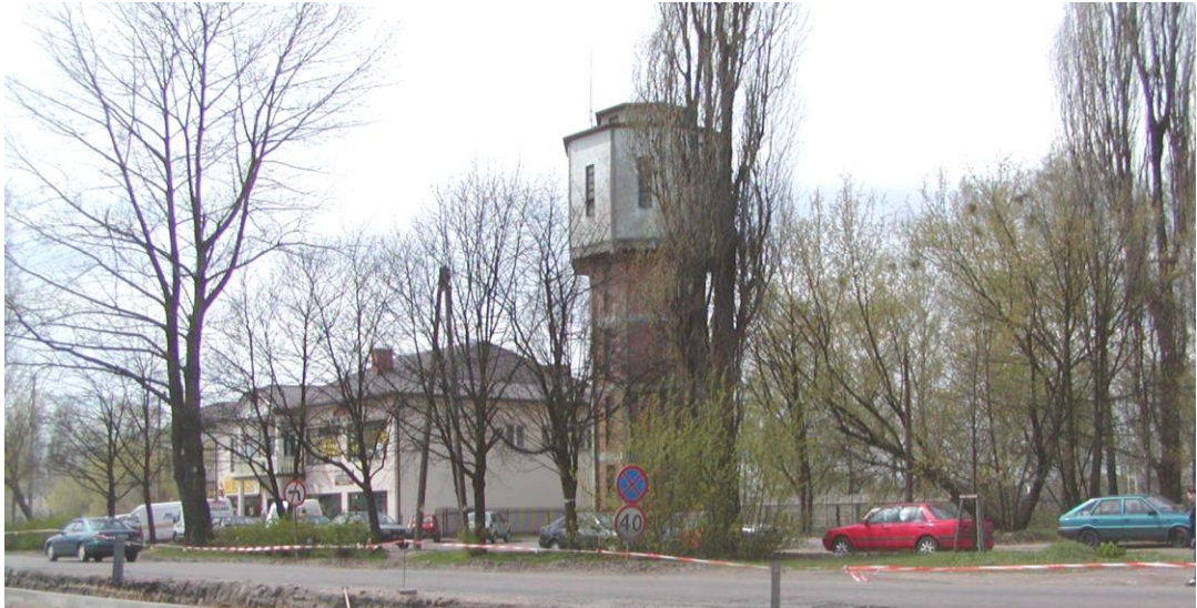
fot. 99 Wieża ciśnień w Łochowie
