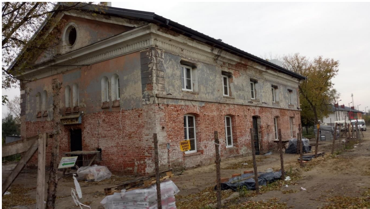
Zdjęcie 8. Elewacja remontowanego budynku dworca
