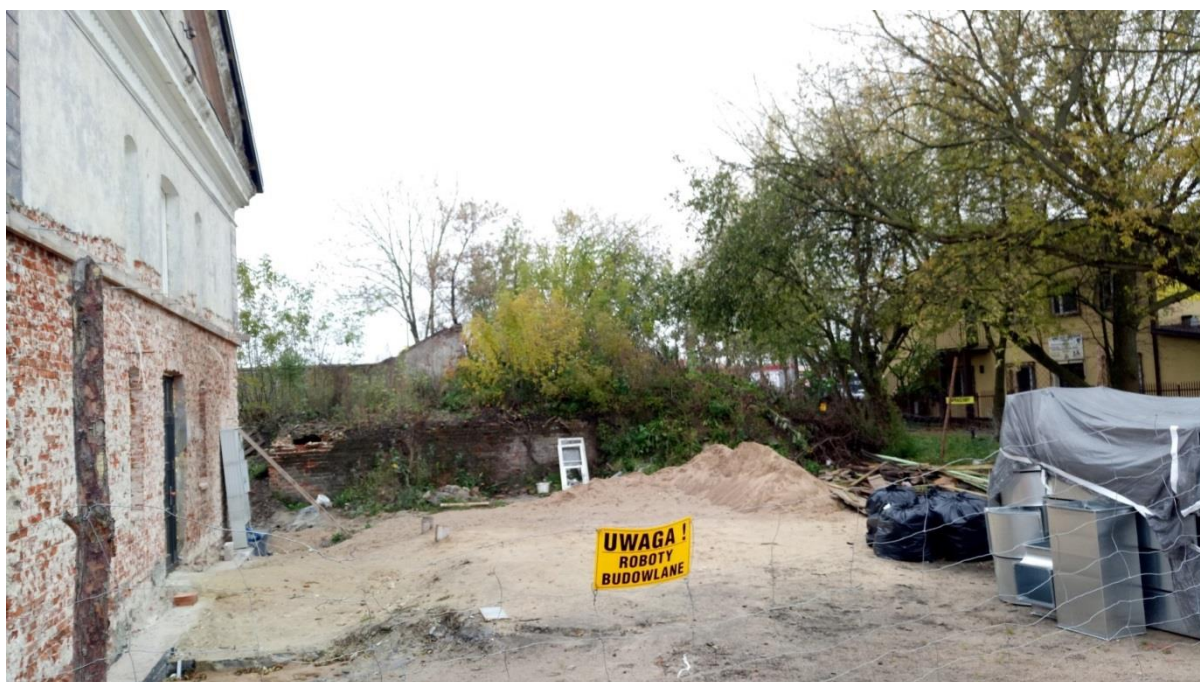
Zdjęcie 9. Zaplecze remontu dworca
