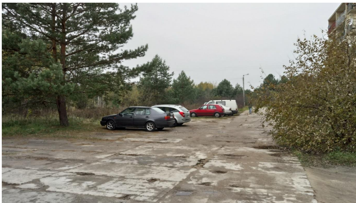
Zdjęcie 45. Parking na płytach z żelbetu
