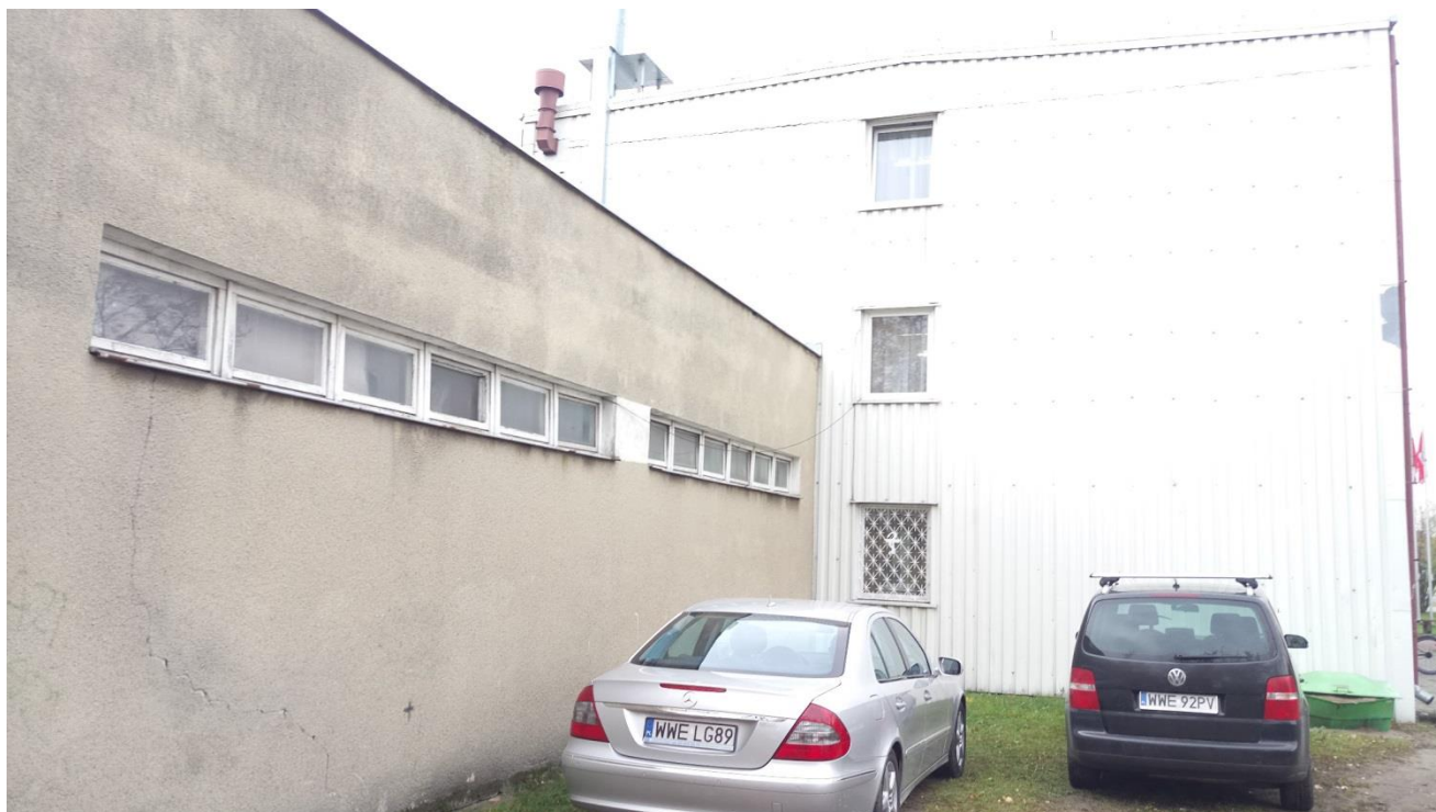
Zdjęcie 3. Urząd Miejski w Łochowie i przyległa kotłownia
