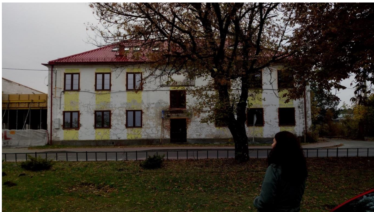
Zdjęcie 59. Remontowany budynek z przeznaczeniem na świetlicę środowiskową
