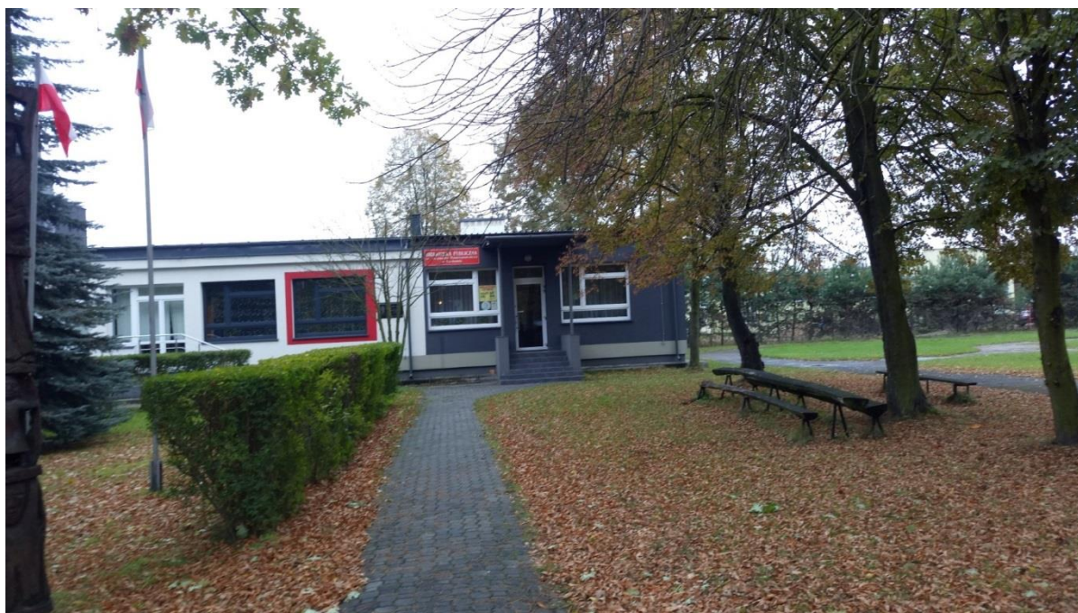
Zdjęcie 22. Budynek biblioteki publicznej przyległy do domu kultury
