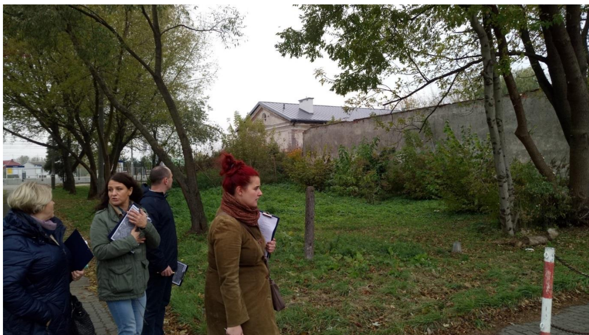
Zdjęcie 13. Zdegradowany budynek dworca – widok od ulicy, DK 50
