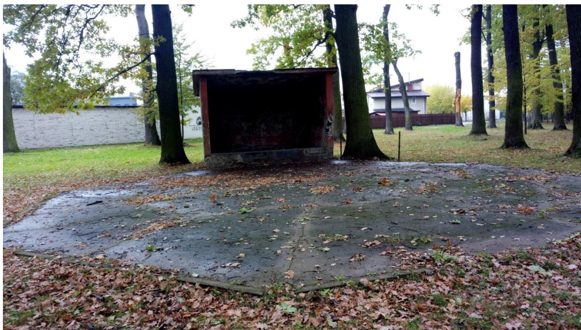
Zdjęcie 26. Zdewastowany amfiteatr z utwardzoną przestrzenią
