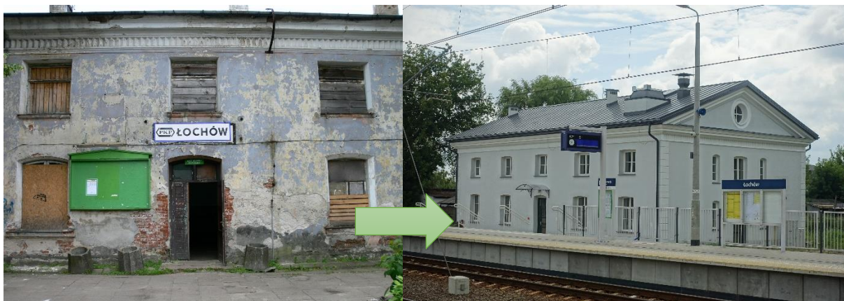
Rysunek 11 Budynek dworca przed i po rewitalizacji
