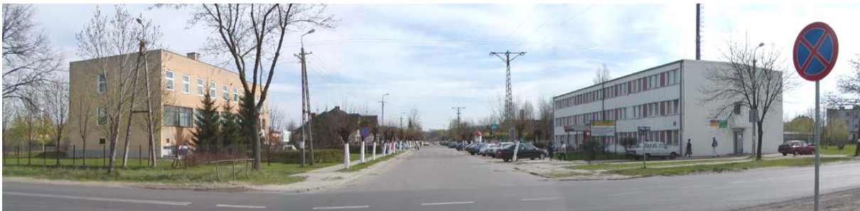
fot. 1 Aleja Pokoju - z prawej Budynek Urzędu Miejskiego.
