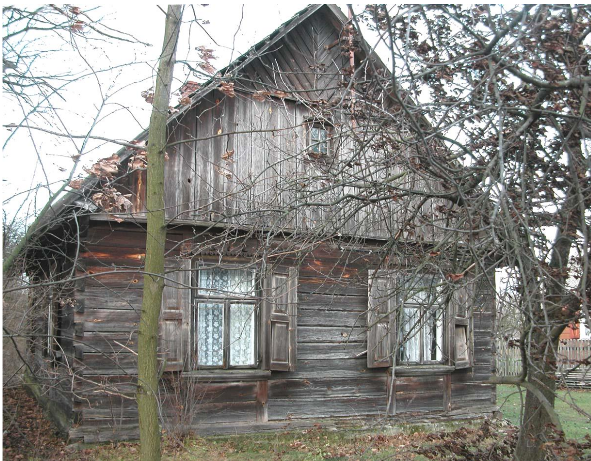
fot. 72 Brzuza - szczyt budynku bez barwnych dekoracji
