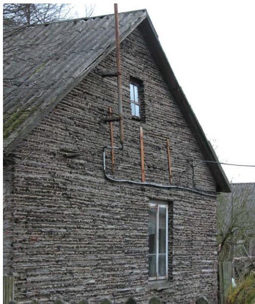
fot. 45 Łosiewice - przykład drewniano-murowanej technologii budowy domów
