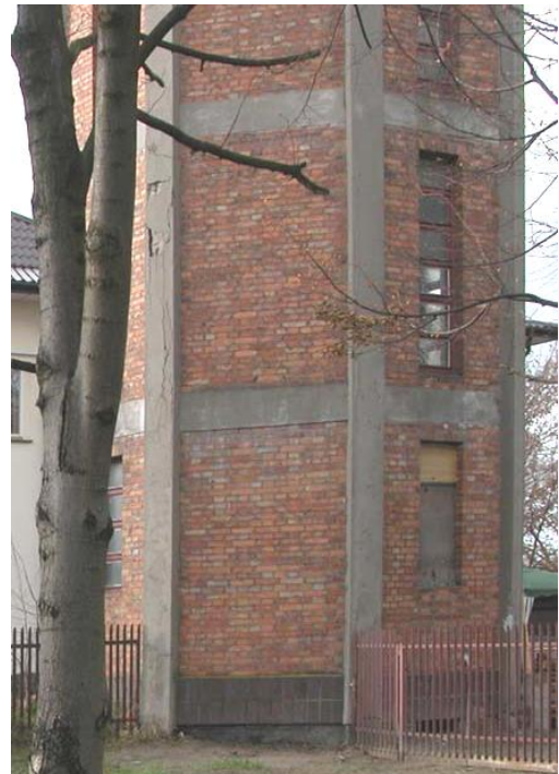
fot. 101 Podstawa Wieży.
