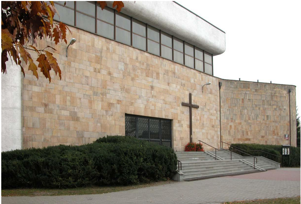
fot. 105 Kościół w Łochowie - wejście główne.
