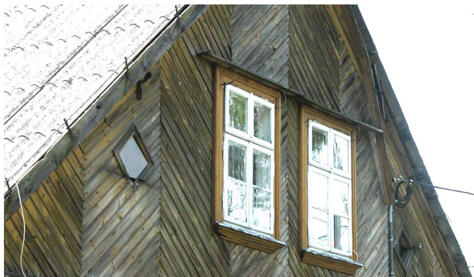
fot. 32 Baczki Fabryczne - szczyt wielorodzinnego domu robotniczego deskowany w jodelkę
