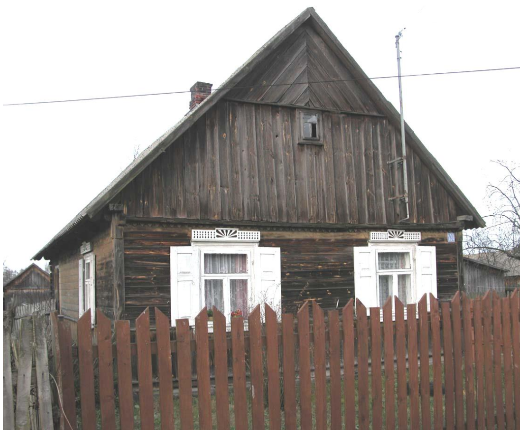
fot. 76 Brzuza - szczyt domu drewnianego i dekoracja okien
