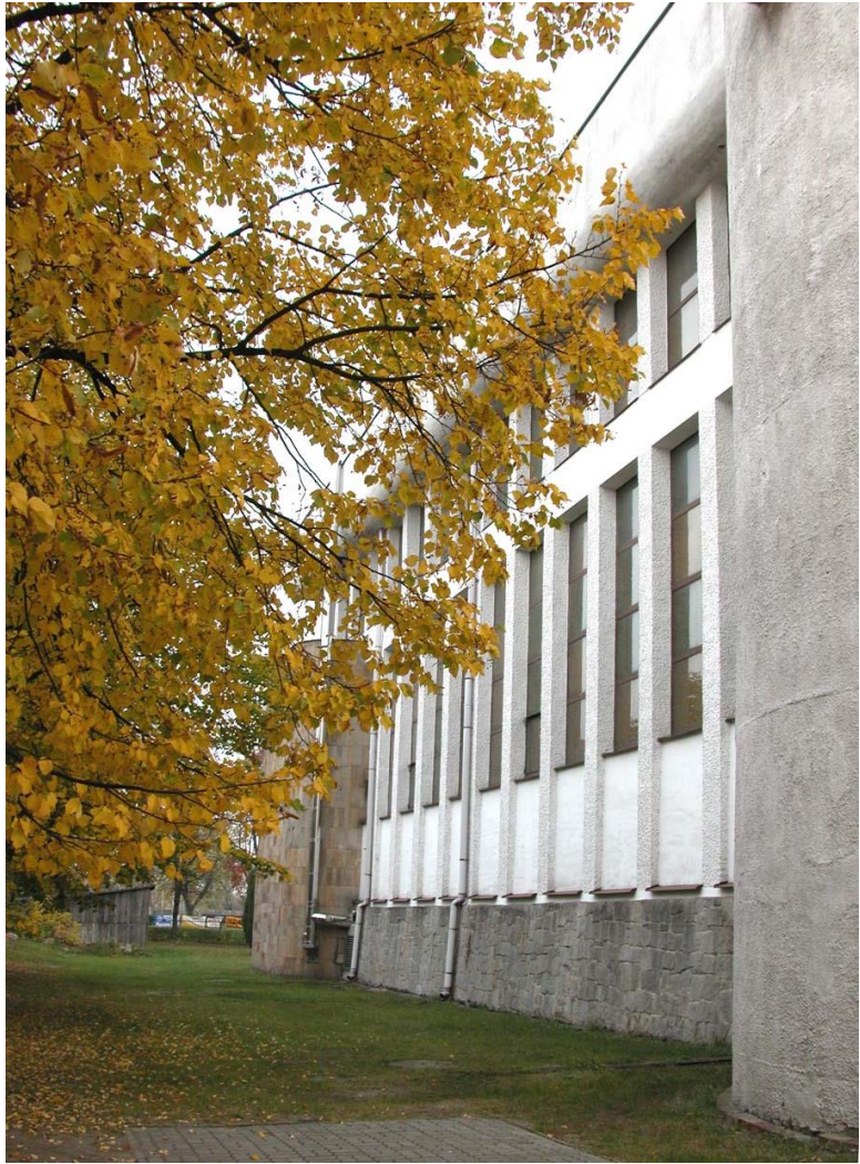
fot. 106 Kościół w Łochowie - elewacja boczna.
