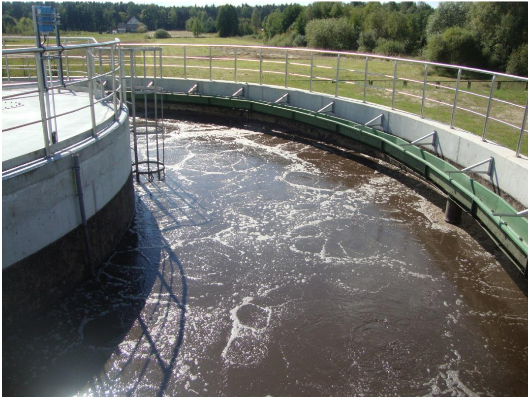
Fot. Reaktor SBR1 - faza napowietrzania (źródło: J.Mech, SZGK Łochów)
