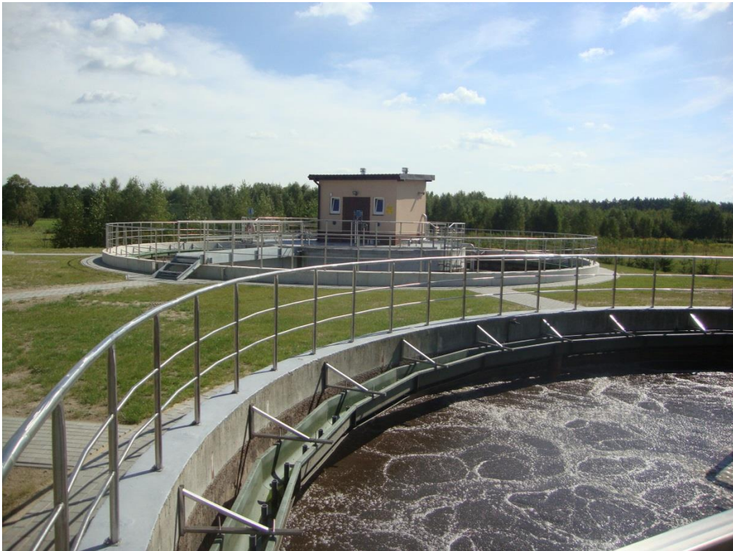
Fot. Reaktory SBR1 i SBR2 (źródło: J.Mech, SZGK Łochów)
