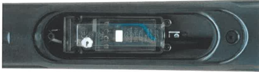
Złącze słupowe we wnęce o zewnętrznej warstwie z tworzywa sztucznego
