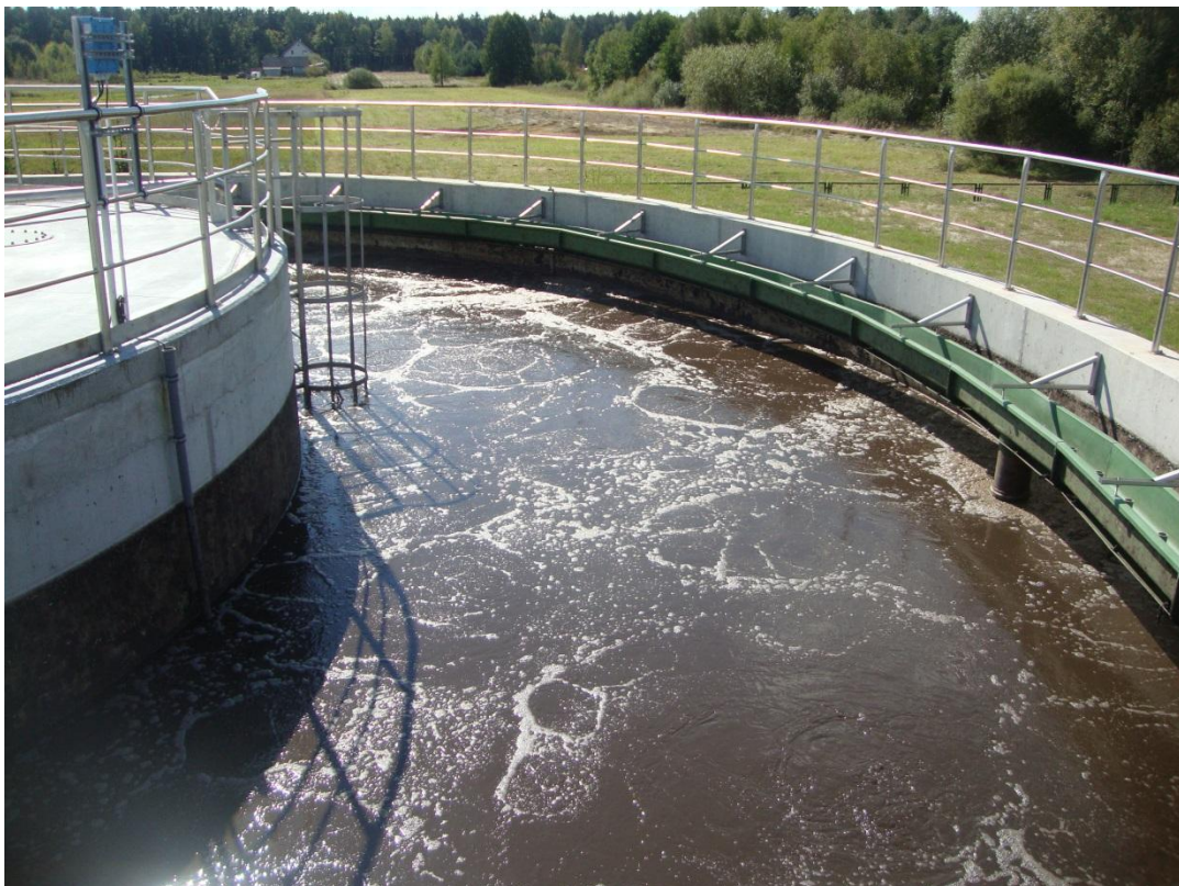
Fot. Reaktor wielofunkcyjny 2 - faza napowietrzania (źródło: J.Mech, SZGK Łochów)
