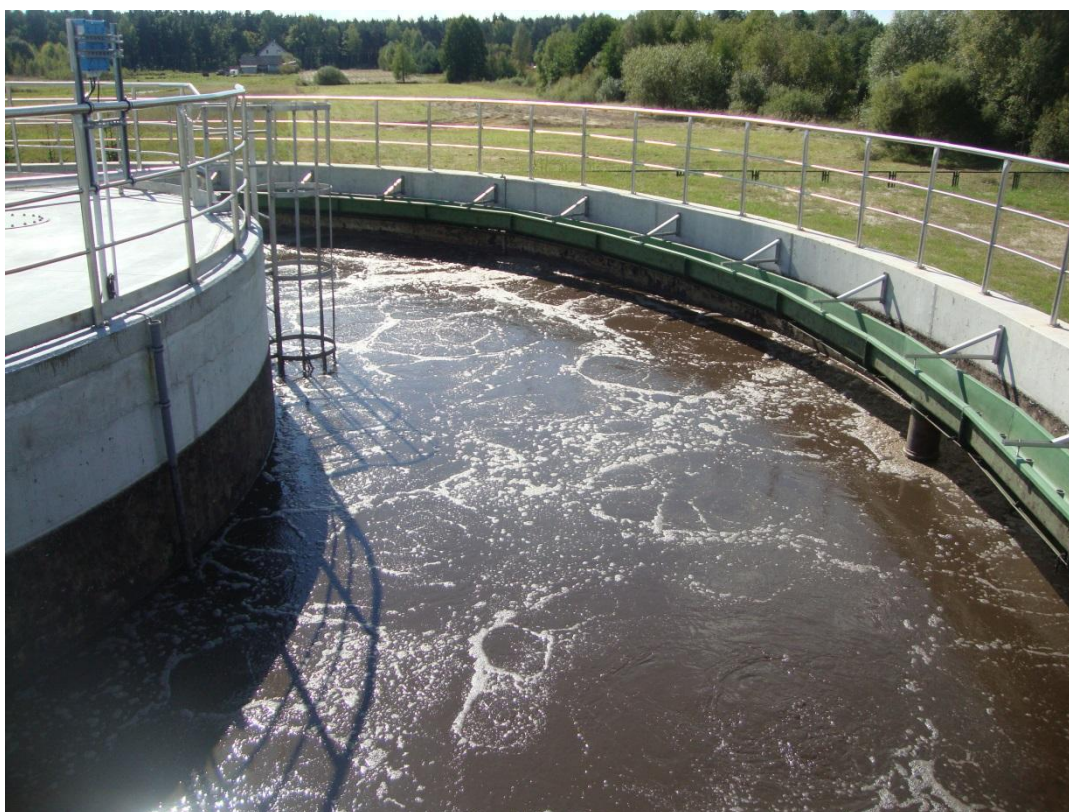
Fot. Reaktor wielofunkcyjny 2 - faza napowietrzania (źródło: J.Mech, SZGK Łochów)
