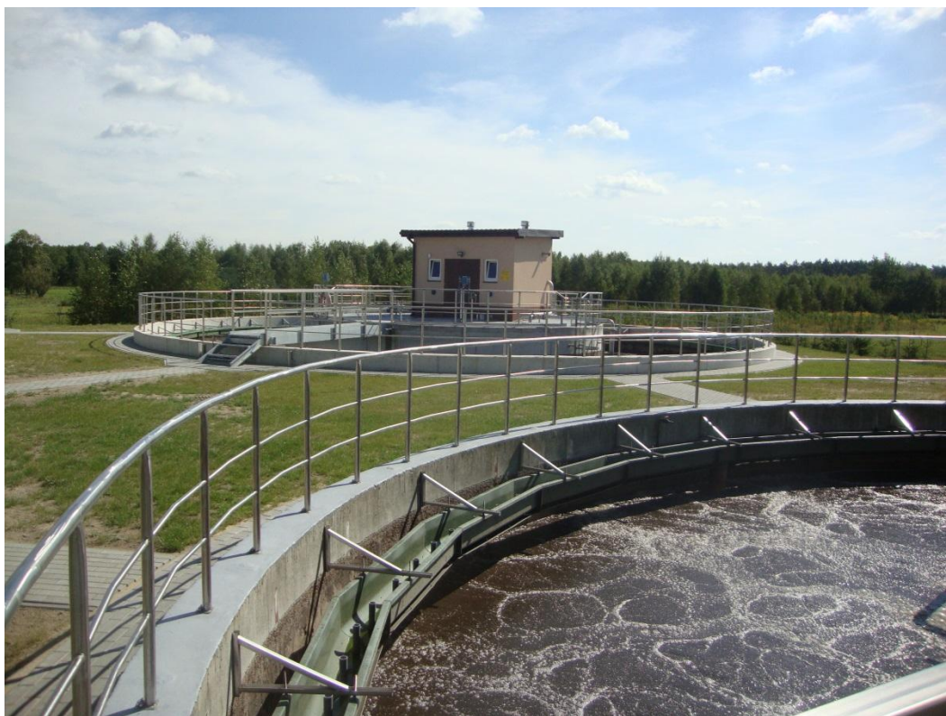
Fot. Reaktory wielofunkcyjne (źródło: J.Mech, SZGK Łochów)
